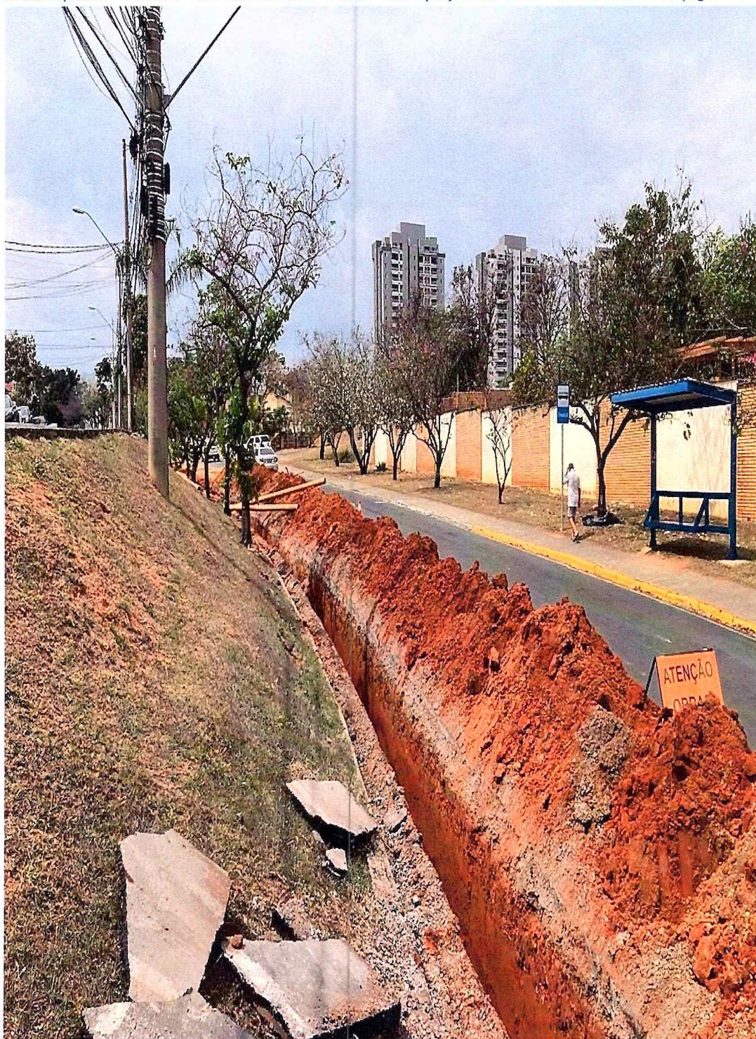
Figura 2 – abertura de vala
