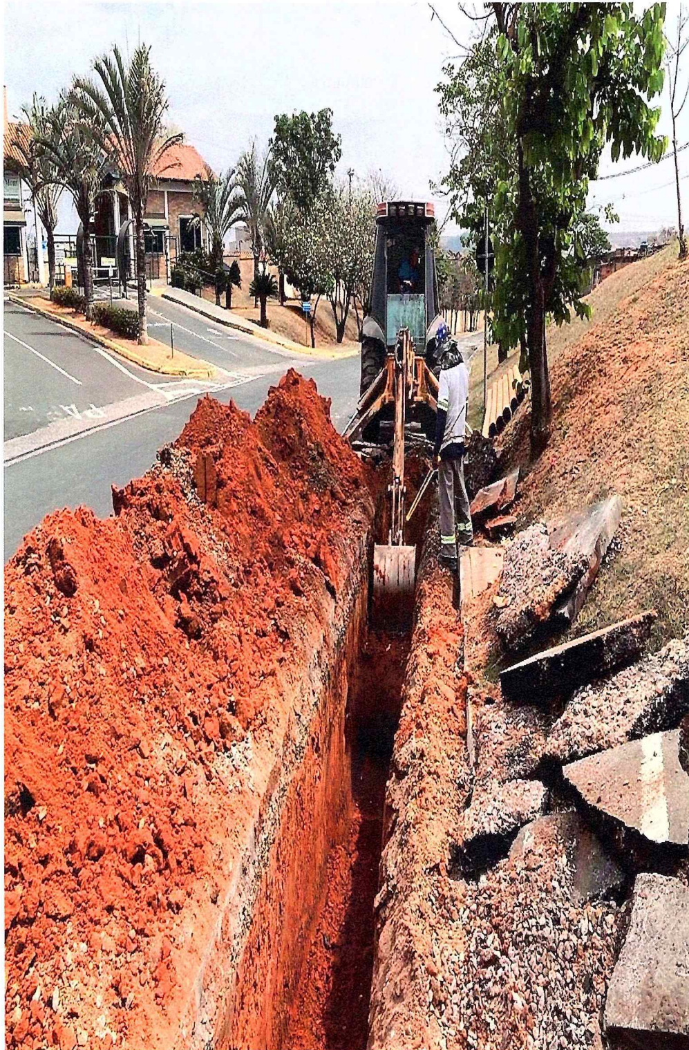
Figura 1 – Abertura de vala
