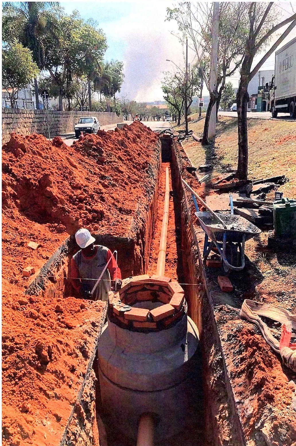
Figura 3 – Assentamento de tubulação e poço de visita
