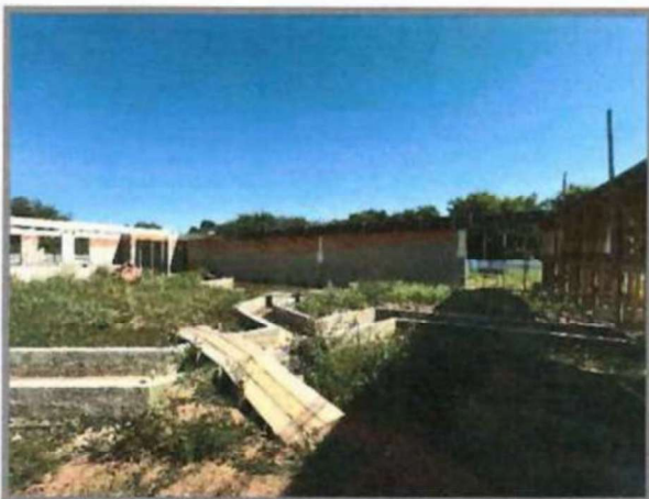
FABRICAÇÃO DE FÓRMA PARA PILARES E ESTRUTURAS SIMILARES, EM CHAPA DE MADEIRA COMPENSADA RESINADA, E = 17 MM. AF. 09/2020
