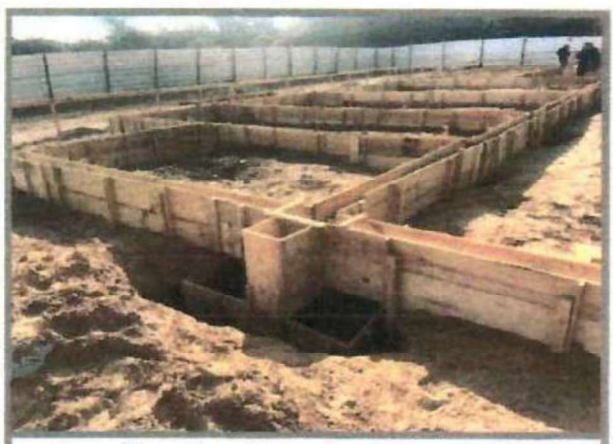
Figura 06: Forma de madeira para arranque dos pilares, Armadura CA-50
