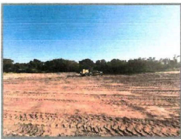
Foto 07: Compactação de aterro mecanizado
