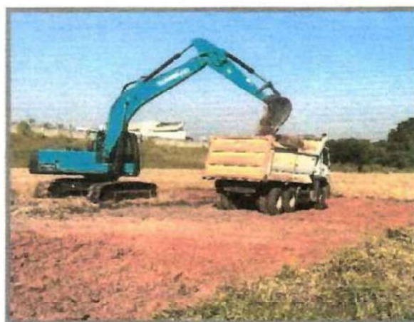
Foto 06: Escavação e carga mecanizada
