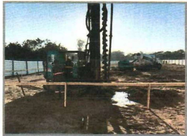
Figura 02: Estaca hélice contínua, armadura CA-50, concreto usinado fck 25MPa
