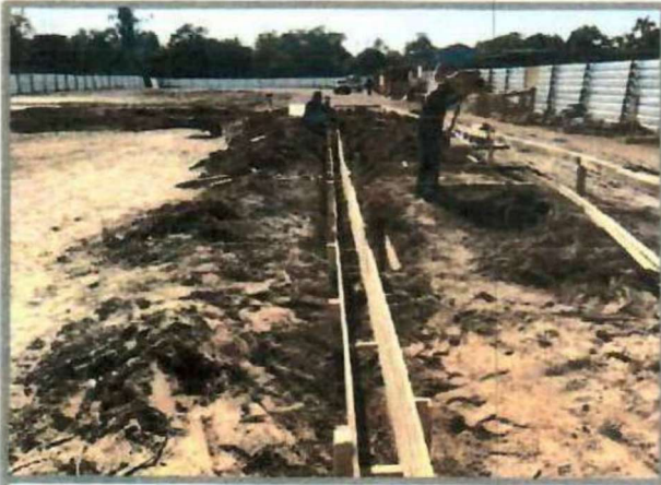
Figura 07: Escavação manual, forma de madeira
