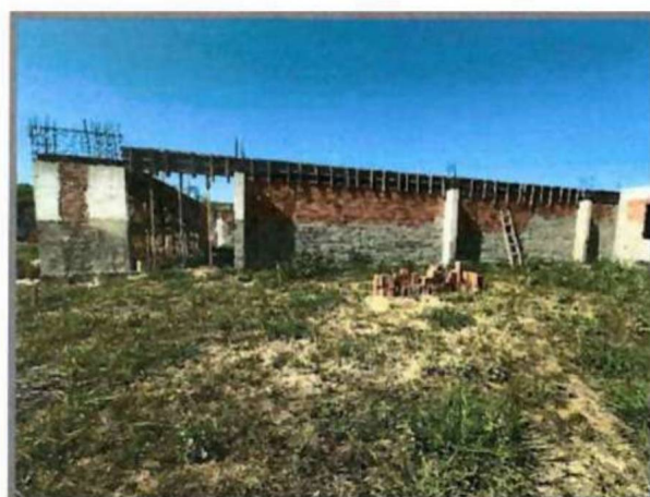
Concreto usinado, fck = 25 MPa
