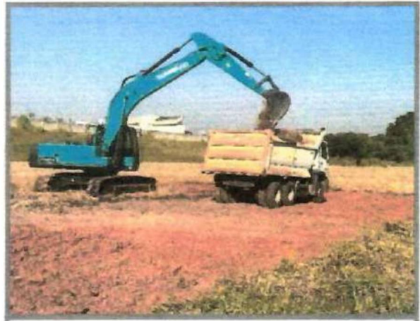
Foto 06: Escavação e carga mecanizada
