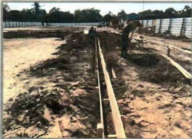
Figura 07: Escavação manual, forma de madeira
