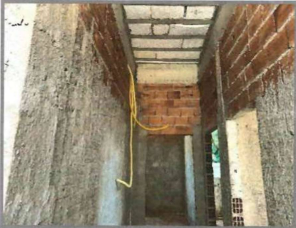
Eletroduto de PVC corrugado flexível reforçado, diâmetro externo de 32 mm
