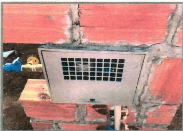
Figura 11: Bloco cerâmico, Entrada de abrigo de água
