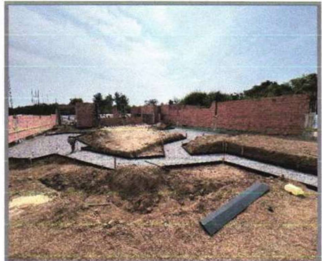
Lastro de pedra britada
