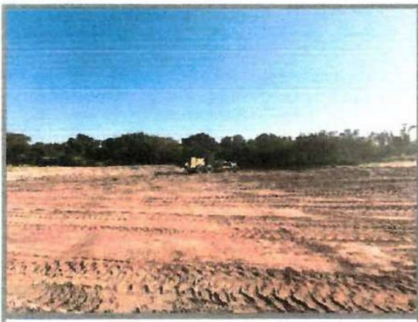
Foto 07: Compactação de aterro mecanizado
