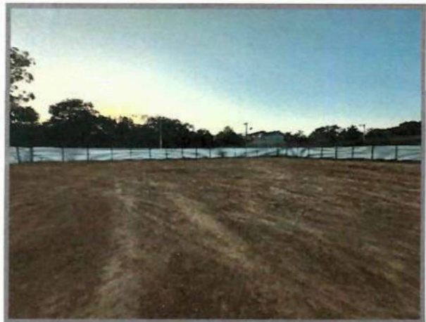
Abertura de caixa até 25 cm, inclui escavação, compactação, transporte e preparo do sub-leito
