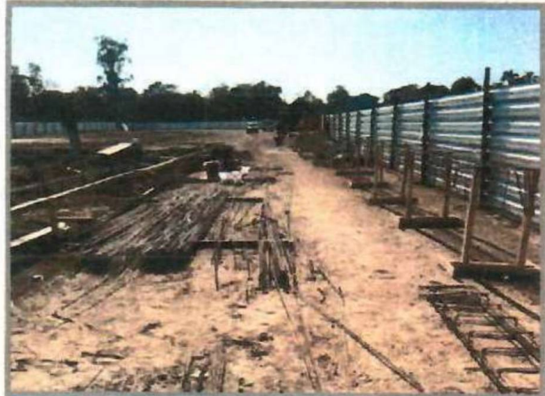
Figura 08: Armadura em barra CA-50
