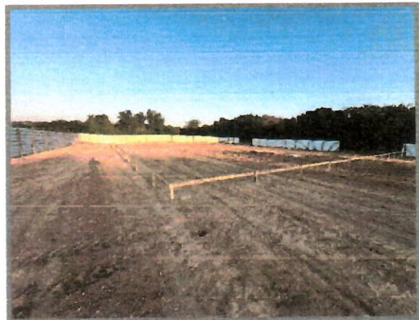
Foto 02: Locação de obra de edificação
