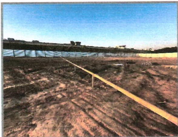
Foto 01: Locação de obra de edificação
