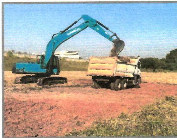
Foto 06: Escavação e carga mecanizada
