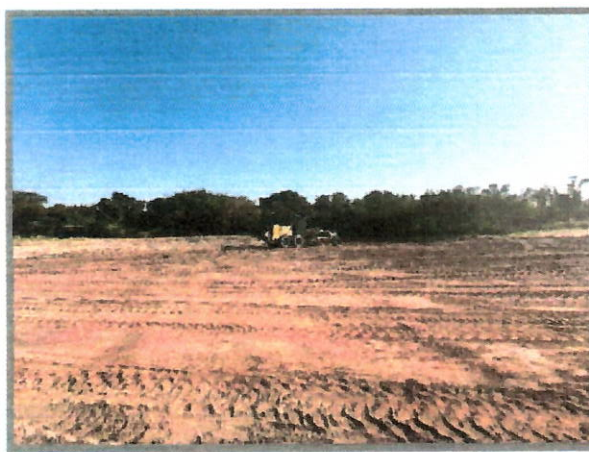
Foto 07: Compactação de aterro mecanizado
