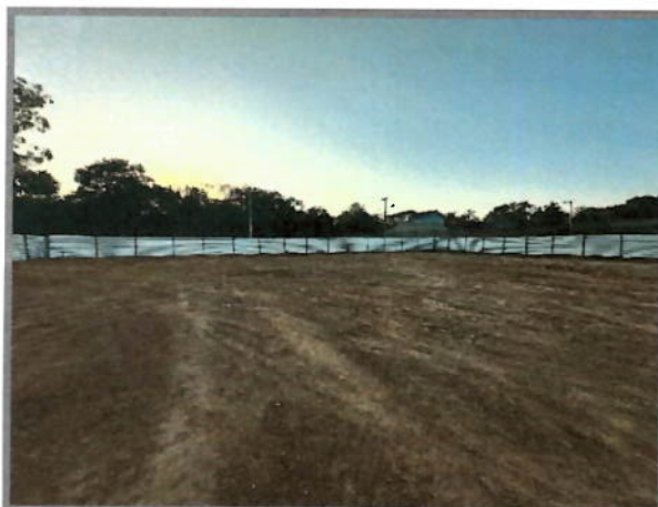
Abertura de caixa até 25 cm, inclui escavação, compactação, transporte e preparo do sub-leito
