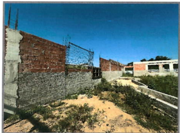
Alvenaria de bloco cerâmico de vedação de 19 cm
