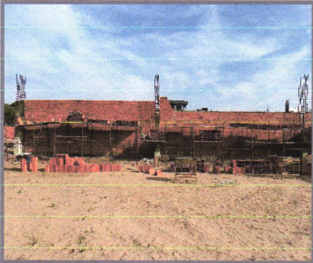
Alvenaria de bloco cerâmico de vedação de 19 cm
