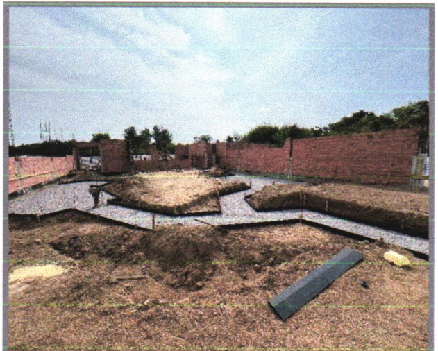
Lastro de pedra britada
