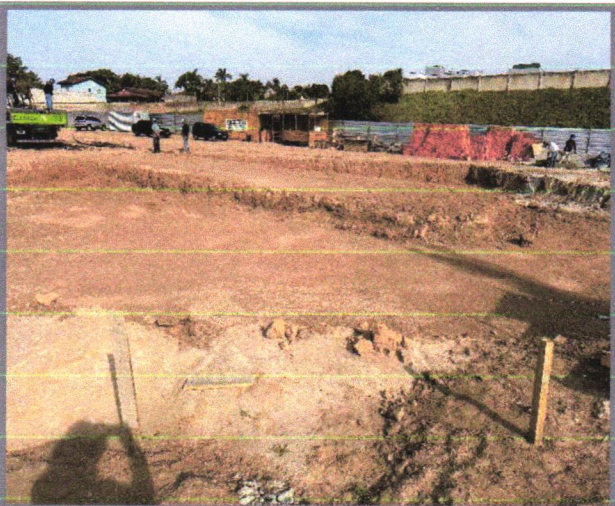
Abertura e preparo de caixa até 40 cm, compactação do subleito mínimo de 95% do PN e transporte até o raio de 1 km
