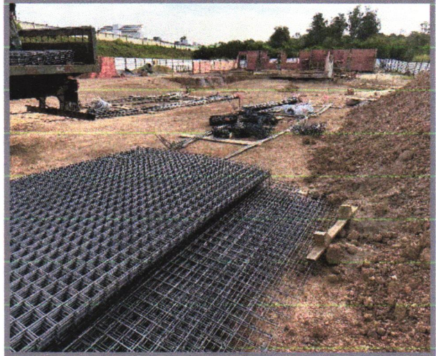
Armadura em barra de aço CA-50 (A ou B) fyk = 500 MPa
