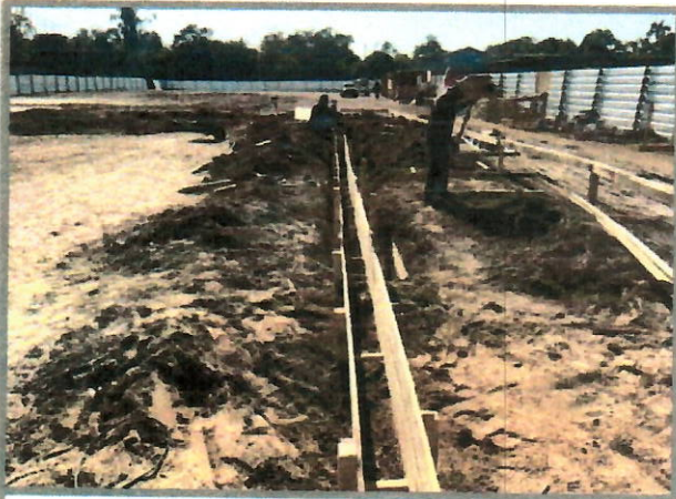
Figura 07: Escavação manual, forma de madeira
