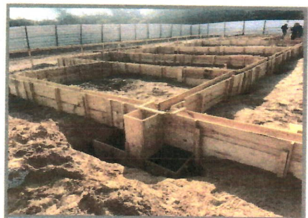
Figura 06: Forma de madeira para arranque dos pilares, Armadura CA-50
