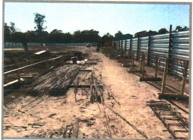
Figura 08: Armadura em barra CA-50
