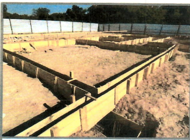
Figura 04: Escavação manual, forma de madeira, Armadura CA-50, Lastro de brita
