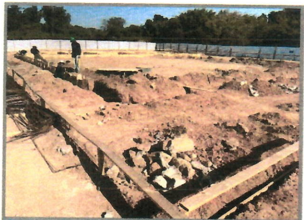
Figura 04: Escavação manual, forma de madeira, Armadura CA-50
